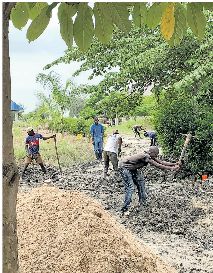
Vorbereitungen am Untergrund der Strasse.
